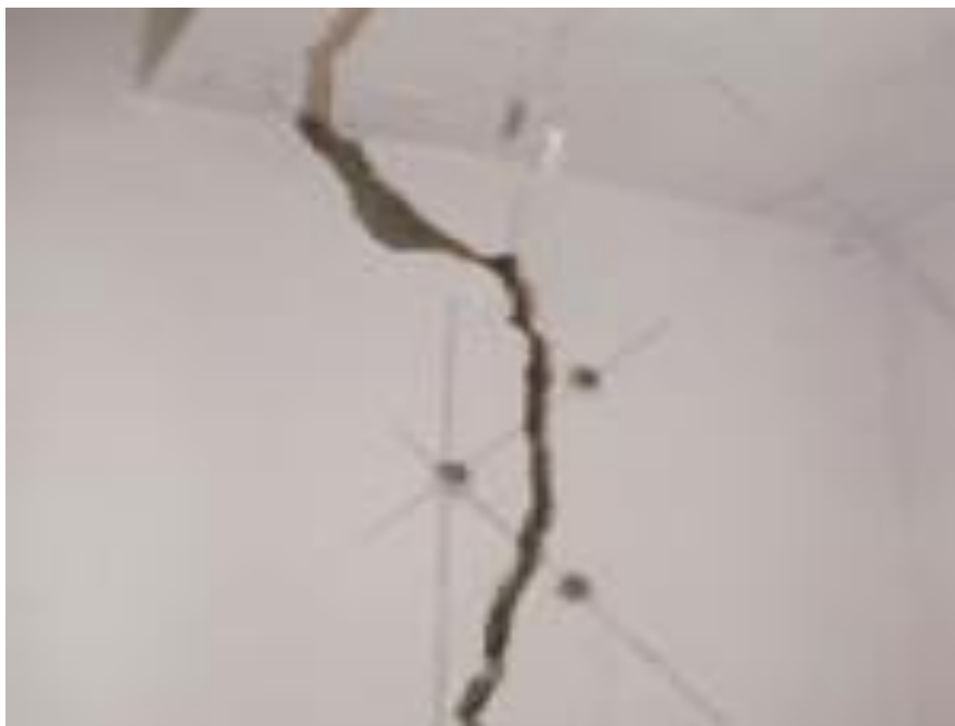
23 Сурет – Аралас (комбинированным) әдіспен –үш нүкте және сызық арқылы жарықшақты бақылау
