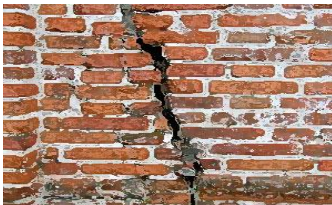
16 Сурет – Жарықшақтардың қабырғада орналасу түрлері
