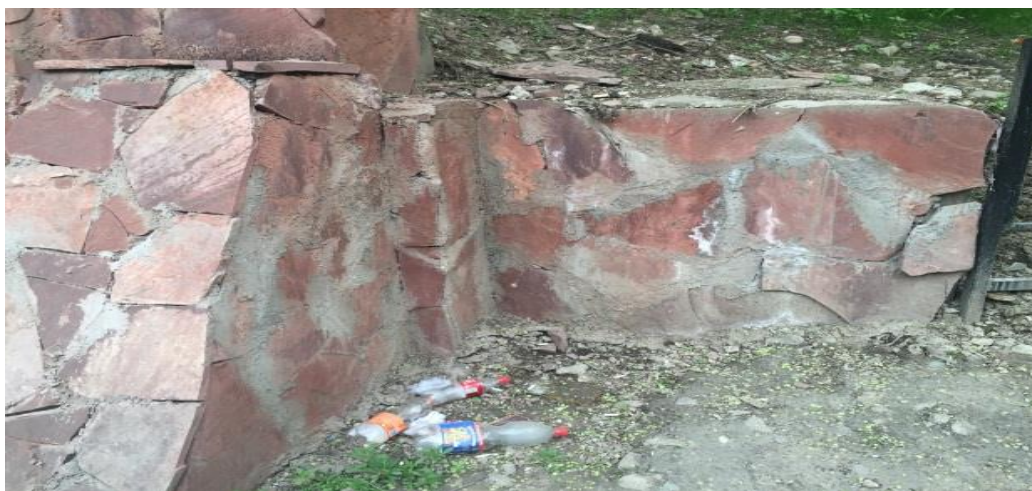
1 Сурет – Ғимараттардың іргетасында болатын жарықшақтану
