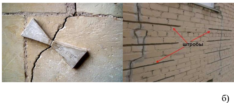
11 Сурет – Ғимарат қабырғасындағы жарықшақтану фрагменттері (а – маяк, б – штроб)
